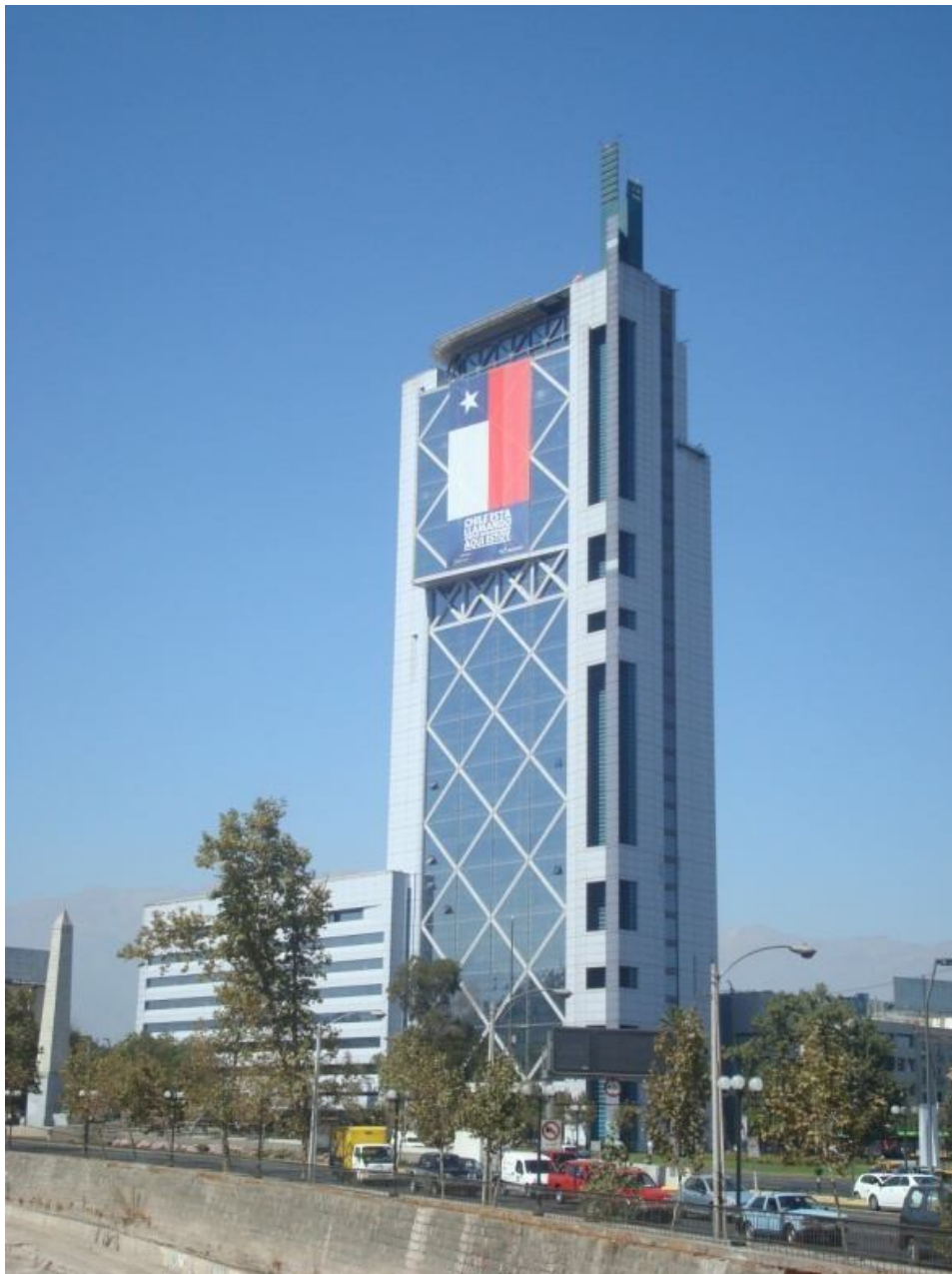
Fig. 8. Edificio de la Compañía de Teléfonos de Chile CTC. Fuente: Fotografía propia.
